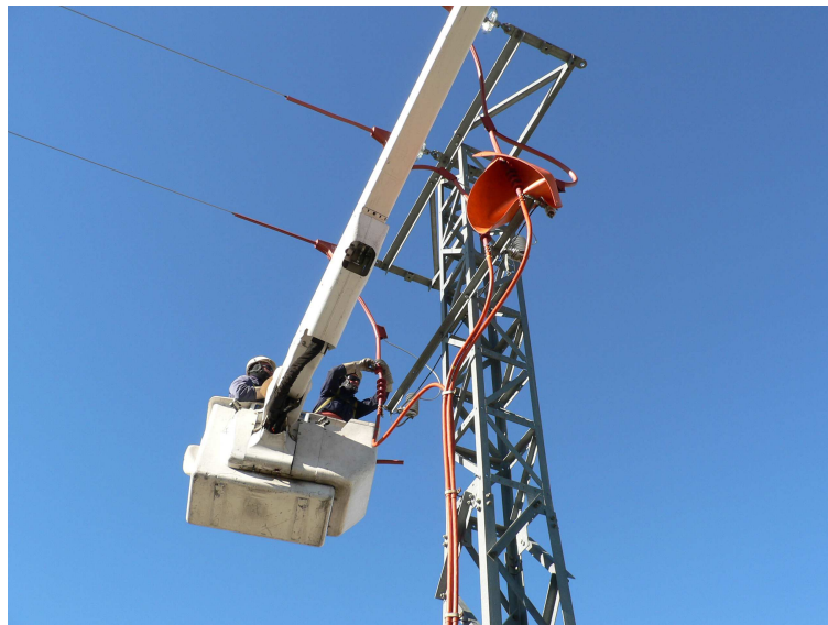
Operarios de Iberdrola realizando las correcciones en los conductores de una de las torretas.
